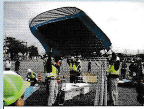
車椅子用トイレ組立
